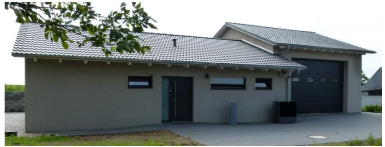
Ansicht Eingangsseite von links
