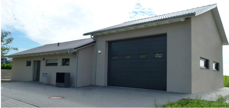
Ansicht Eingangsseite von links
