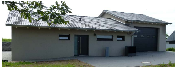
Ansicht Eingangsseite von links
