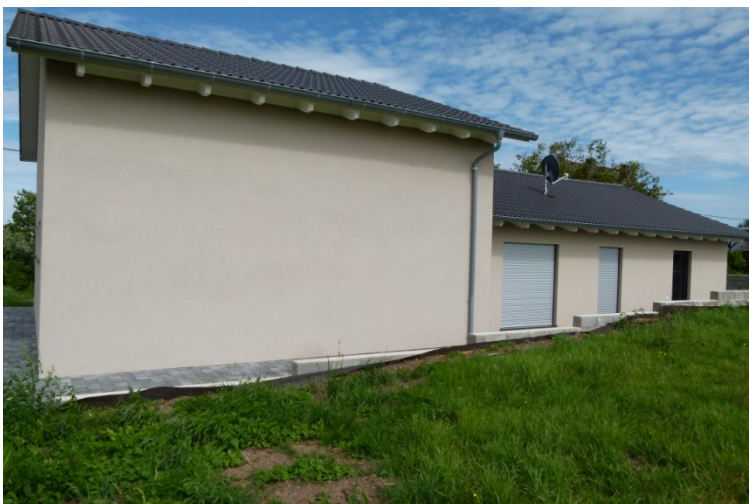
Ansicht Rückseite, Garage
