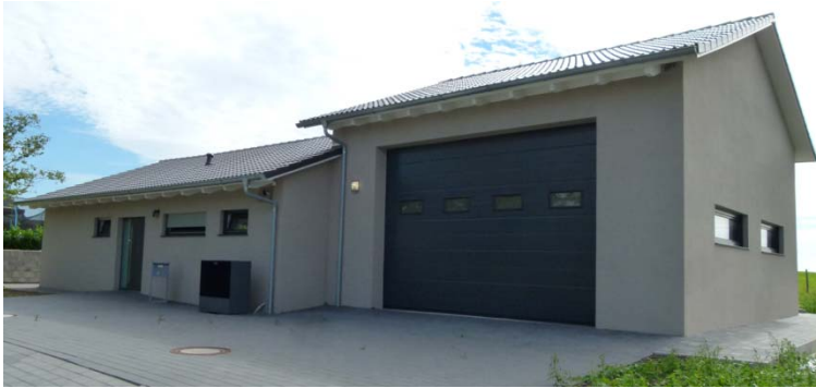
Ansicht Eingangsseite von links
